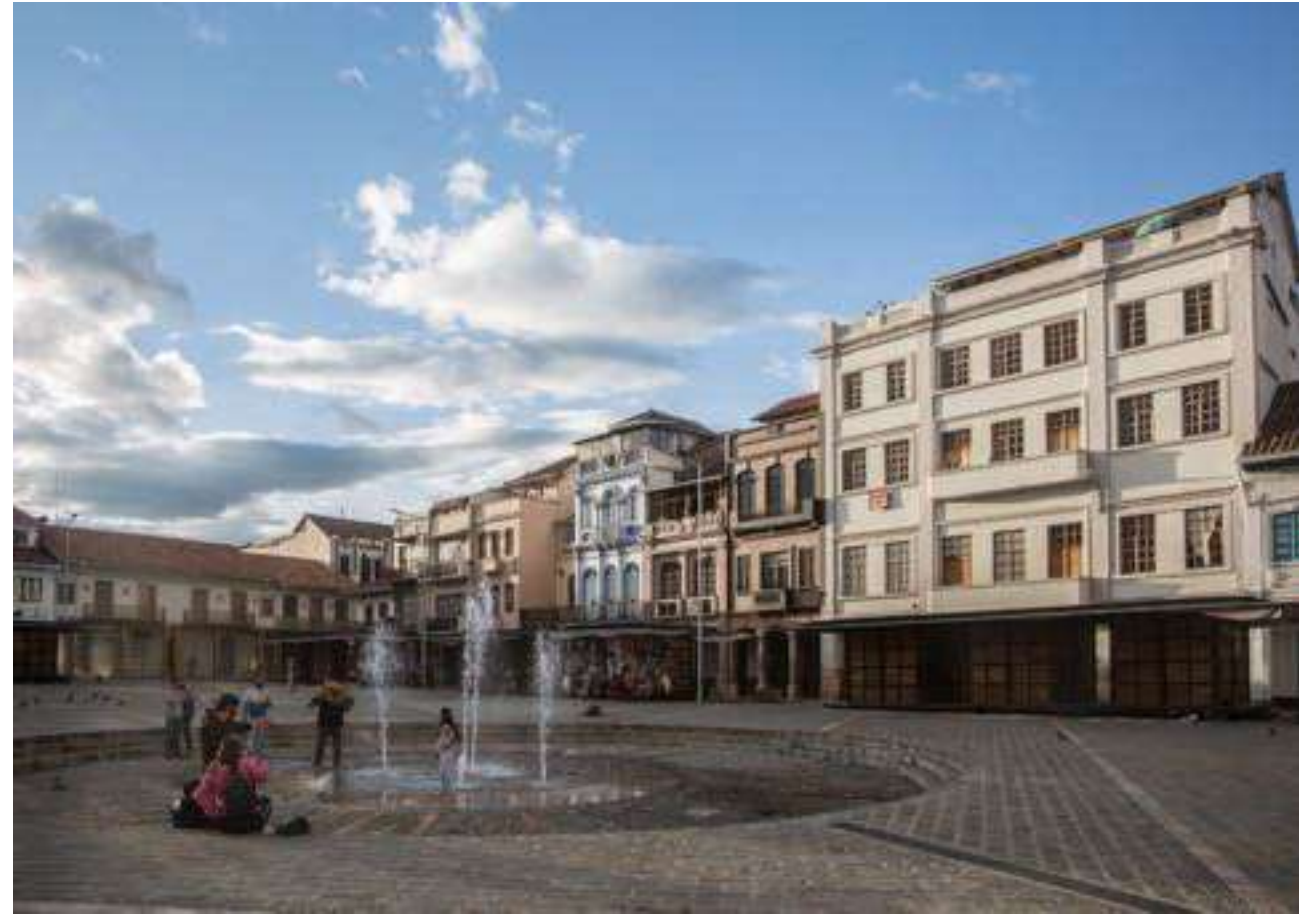
Plaza San Francisco, tradicional mercado popular, rehabilitada entre 2017 y 2019.
