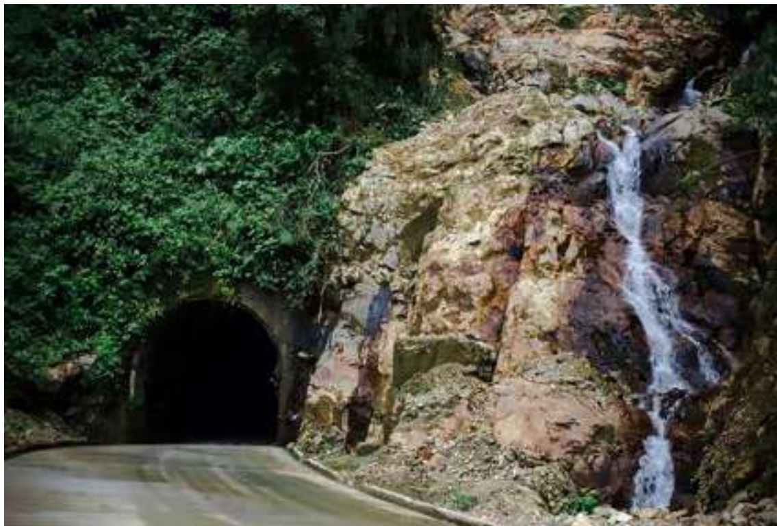
Túnel de Guarumales en la Avenida de las Cascadas.
